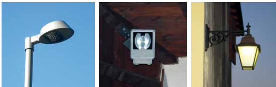
Alcune tipologie architettoniche dei corpi di illuminazione: corpo tecnico su palo con sorgente a LED, proiettore sottogronda con sorgente in alogenuri metallici, corpo artistico a parete con sorgente a sodio ad alta pressione.
